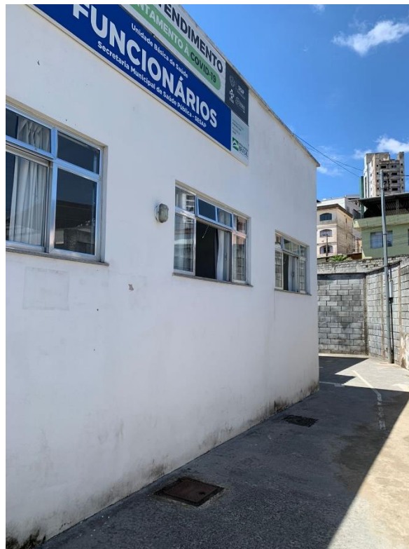
Figura 13 – Fachada da UBS atualmente Fonte: Arquivo pessoal – Cristiane Dornelas Saviotti
