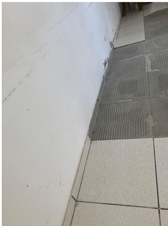
Figura 9 – Rodapé a ser demolido Fonte: Arquivo pessoal – Cristiane Dornelas Saviotti
